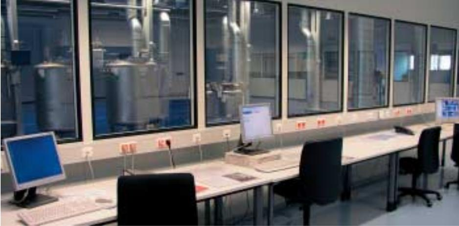
Steuerzentrale der Kryoforschungsbank mit automatischer Überwachung und Versorgung von Kryobehältern.
