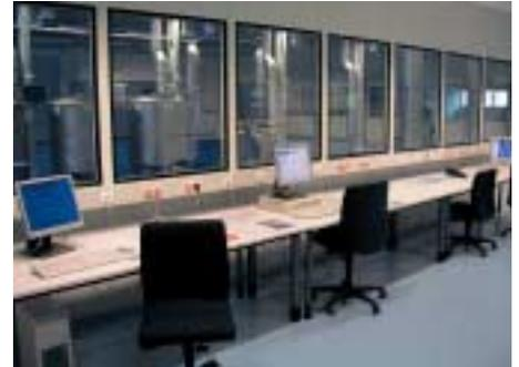
Die gesamte Kryobank wird von einer Zentrale aus überwacht. Hier laufen alle Signale der Kryolagerbehälter, der Alarmanlage, der Videoüberwachung und der Lüftungsanlage zusammen.
